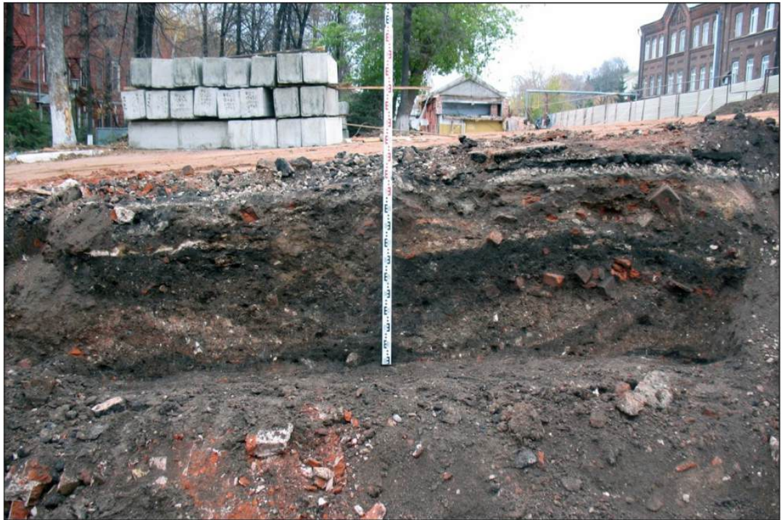
Илл. 25. Н. Новгород. Зона демонтажа здания на Нижне-Волжской набережной, 1/1. Котлован. Зачистка №1. Вид с запада-юго-запада.
