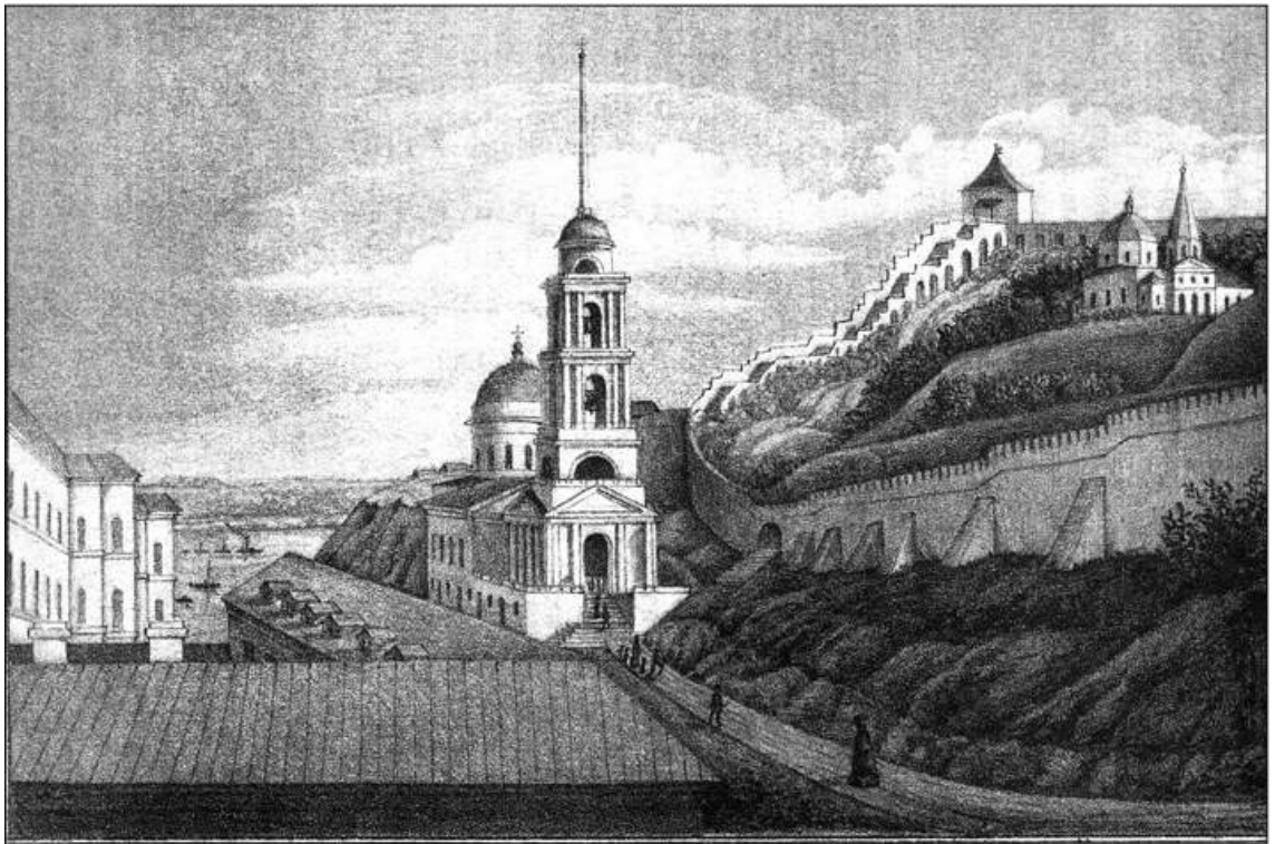
Илл. 18. Живоносновская церковь. Вид с запада. Слева Западный корпус казарм со вспомогательными постройками (службами). Гравюра Д. А. Быстрицкого, сер. XIX в.
