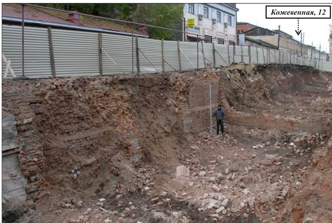
Илл. 24. Н. Новгород. Зона демонтажа здания на Нижне-Волжской набережной, 1/1. Котлован, восточная часть южного борта. Вид с северо-востока.
